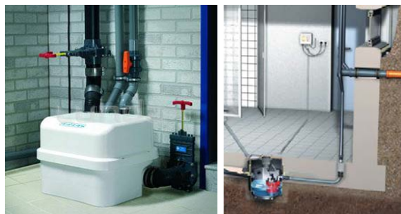
Figur 10 - Exempel på uppfodringsanordningar med bakvattenloop som vanligtvis används i Sverige som avloppspump för anslutningar under kanalnivån (SANICUBIC) och ett speciellt för bakvattenskydd utvecklat system med dold placering (Kessel AG).
